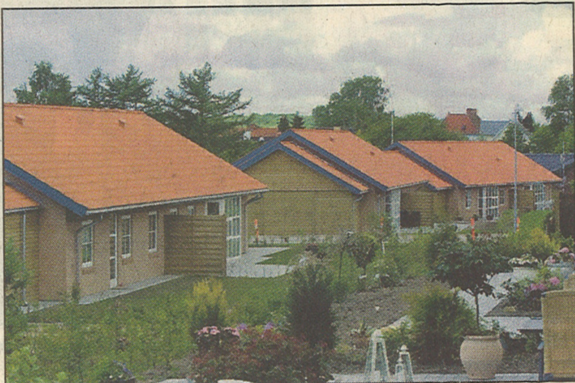
Her ses nogle af dobbelthusene som byggefirmaet Jørgen Jensen Skårup A/S opfører. Bygningerne her er fra Rødbyhøjen på Thurø.
